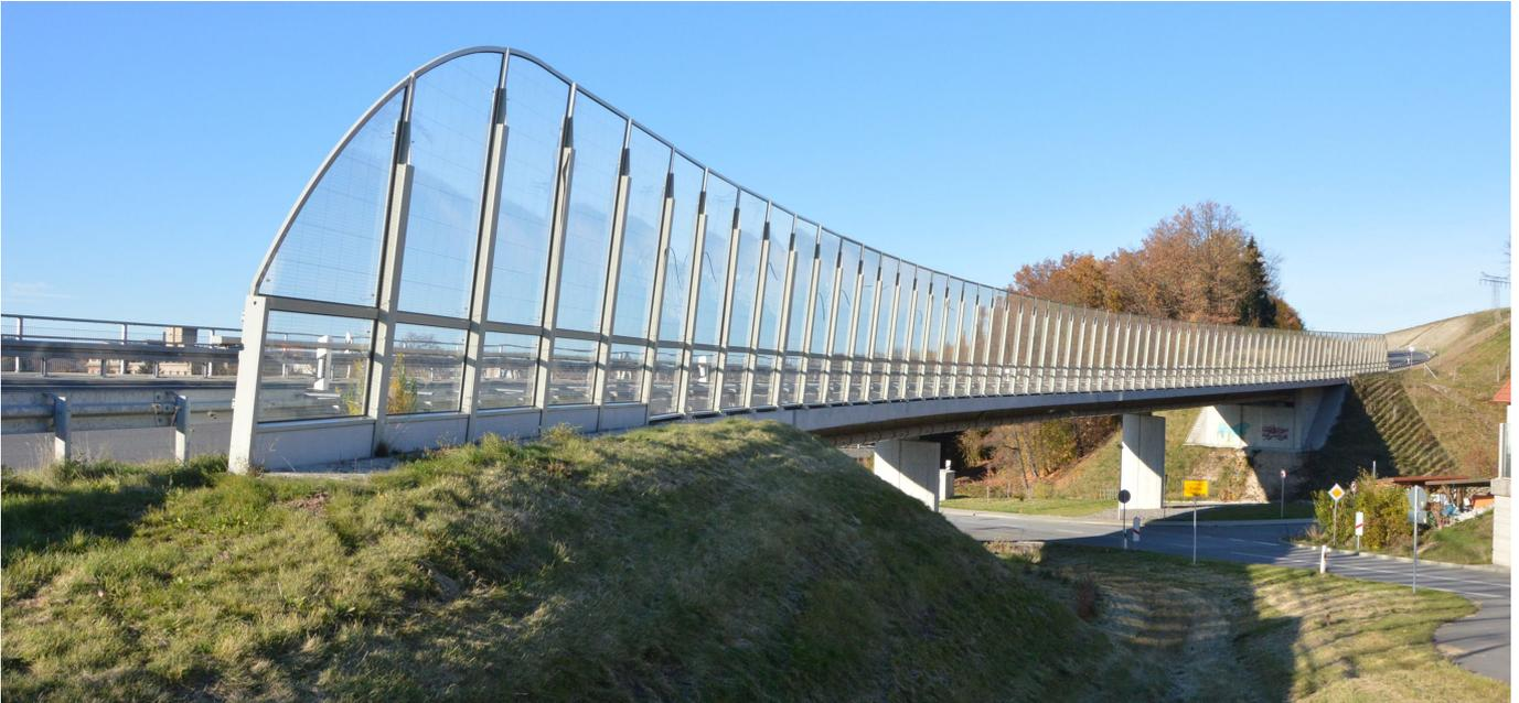
Zur Entlastung des Zentrums der Stadt Flöha entsteht die anbaufreie südliche Umgehung (B 173n) und deren Verknüpfung mit der B 180 und der S 223. Die ausgeführte Brücke kreuzt im spitzen Winkel die Augustusburger Straße. Das Brückenbauwerk wurde als Spannbetonbrücke mit einem durchlaufenden Mittelträgerquerschnitt über 3 Felder ausgeführt.
