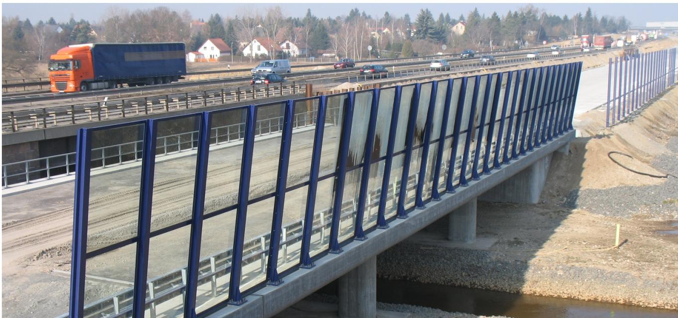
Die BAB A 14 wurde zwischen der AS Leipzig-Messegelände und der AS Leipzig-Ost von 4 auf 6 Fahrstreifen, d. h. auf einen Regelquerschnitt RQ 35,5, verbreitert. Die Arbeiten begannen 2007 mit den Bauwerken 32 bis 34 in der Richtungsfahrbahn Magdeburg, die Verkehrsfreigabe erfolgt im Juli 2012. Kernstücke im Abschnitt sind das BW 33 über die B 87 und die Straßenbahngleise Richtung Taucha an der Anschlussstelle Leipzig Nord-Ost sowie das BW 34 über die Gleisanlagen der DB AG.
