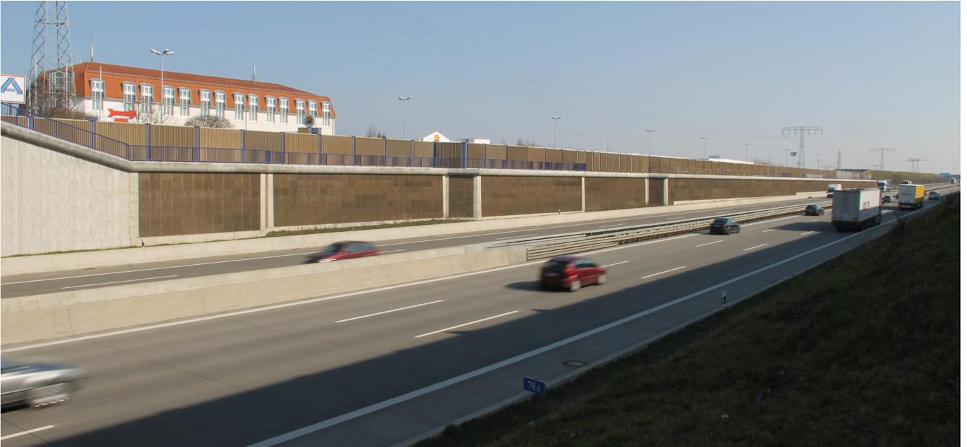
Die BAB A 14 wird zwischen der AS Leipzig-Messe Gelände (O.), Betriebs-km 80,200 (Bau-km 0+000) und der AS Leipzig-Ost, Betriebs-km 72,840 (Bau-km 7+360,095) von 4 auf 6 Fahrstreifen, d. h. auf einen Regelquerschnitt RQ 35,5 verbreitert.
