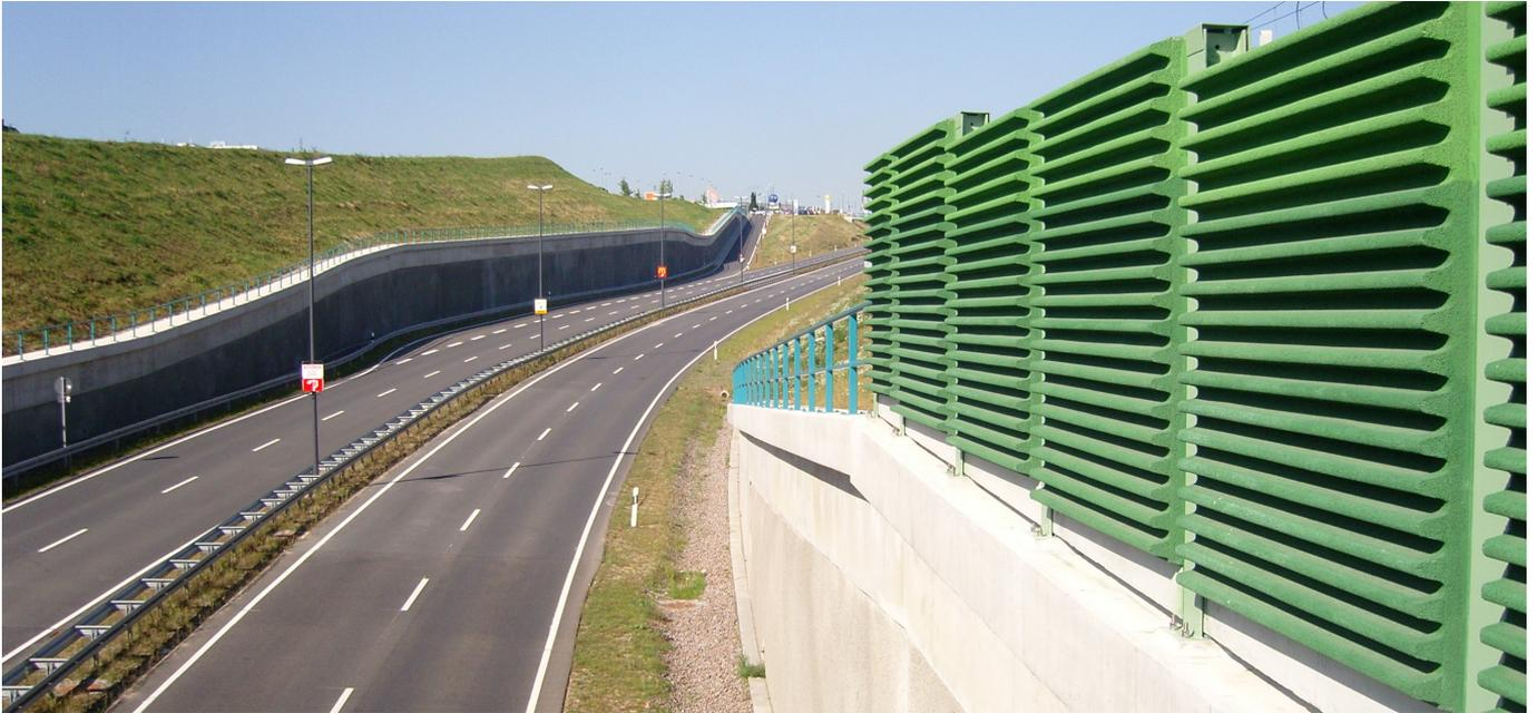
Der Niveaueingleich zwischen Tiefenlage der B 173 und dem anschließenden Gelände, einschließlich der Sicherung privater Grundstücke, erforderte Stützwände. Diese Wände wurden teilweise mit Lärmschutzkonstruktionen ausgestattet.
