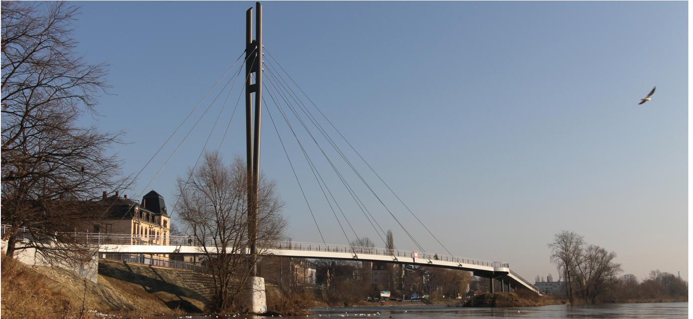
Der neu gebaute Abschnitt des Elberad- und Wanderweges zwischen Moritzburger Straße und Leipziger Straße in Dresden hat eine Länge von 670 m. Davon wurden 151 m als Brückenbau und 519 m als Verkehrsanlage ausgeführt. Der größte Teil des Weges verläuft auf einer Hafenterrasse, die durch einen Stahlbetontrog auf der Dammkrone zur Erlangung der erforderlichen Verkehrsbreite erweitert wurde.
