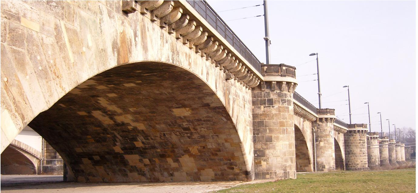
Die Sanierung der im Jahre 1852 errichteten Sandstein-Bogenbrücke umfasste nicht nur die Instandsetzung des Unterbaus, sondern auch eine Verbreiterung um 3,50 m zugunsten einer störungsfreien parallelen Lage von Straßenbahn und Individualverkehr.
